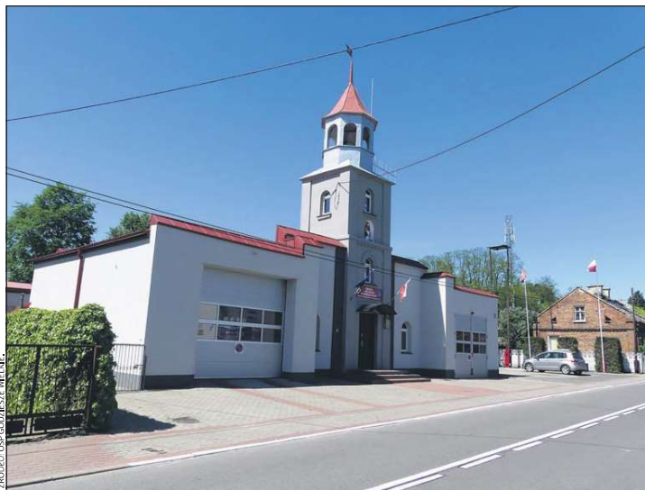
Przy wsparciu środków UE w ramach inicjatywy LEADER OSP w Godzieszach Wielkich zrealizowało inwestycję polegającą na gruntownym remoncie strażnicy.
