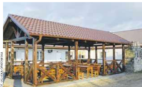
FOT. LUG ŁĘKA OPATOWSKA Wiata rekreacyjna w miejscowości Piaski w gminie Łęka Opatowska powstała dzięki pomocy unijnego funduszu rolnego. WPR przewiduje dofinansowanie na kolejne tego typu obiekty.
