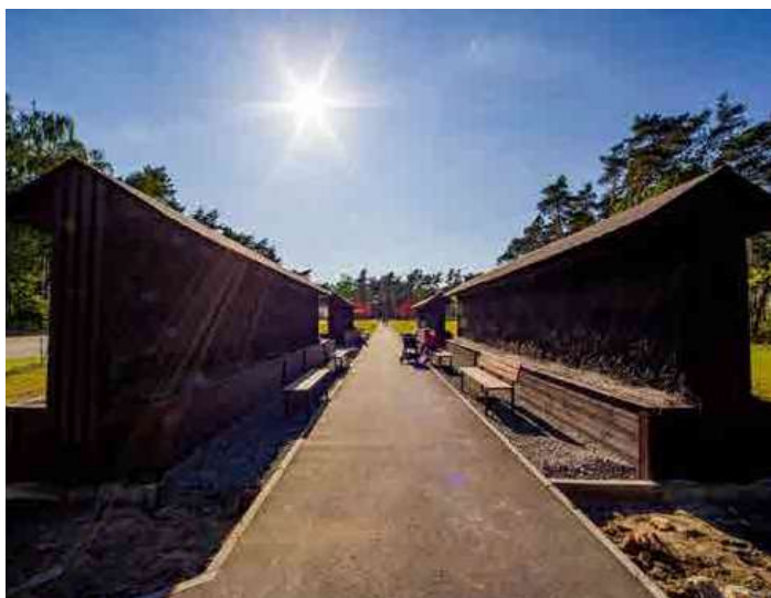
Tężnie solankowe w Ślesinie to efekt inwestycji dofinansowanej z PROW 2014-2020 w ramach realizacji inicjatywy LEADER. Źródło: UG Ślesin.
