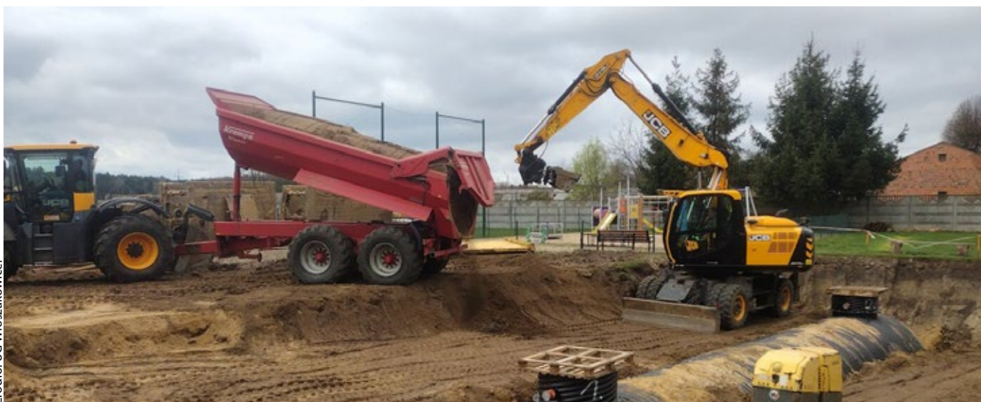
Budowa zbiornika retencyjnego w Jezierzycach Kościelnych w gminie Włoszakowice to jeden z elementów projektu dofinansowanego z PROW 2014-2020.
